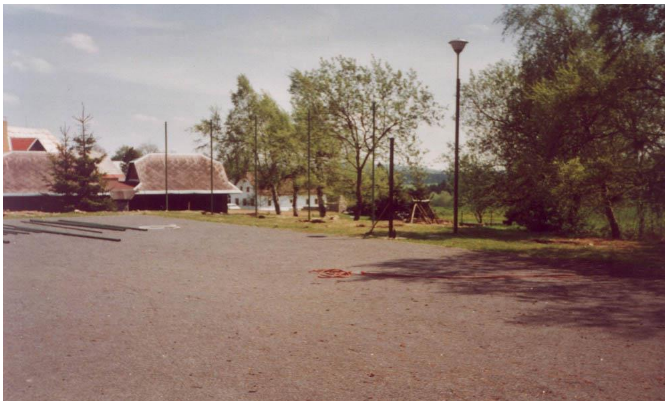
Obrázek 34 2002 Výstavba oplocení nohejbalového hřiště
